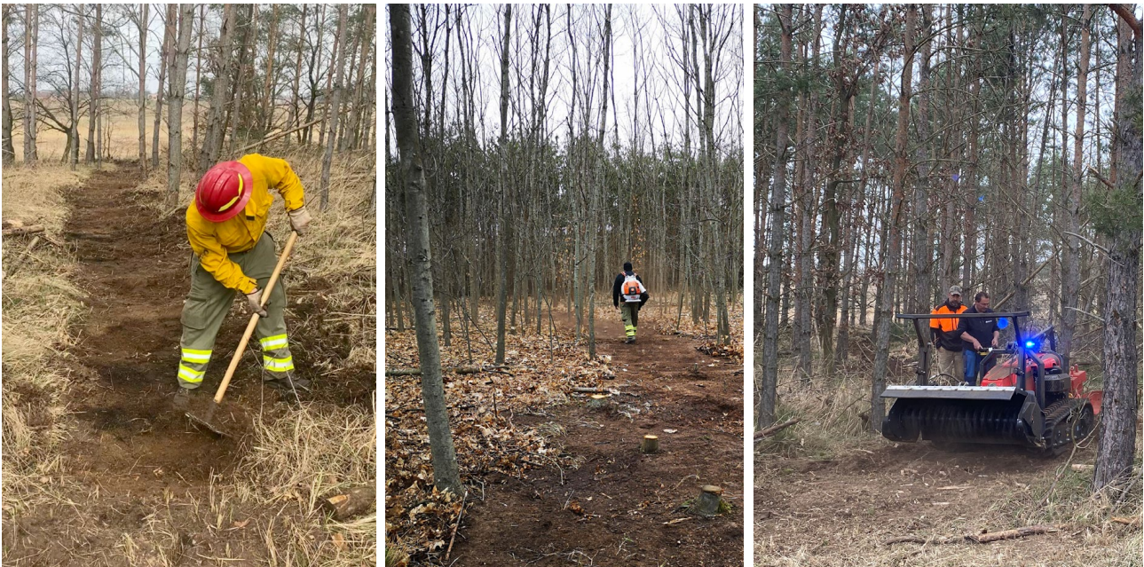
Abbildung 15: Beispielhafte Methoden zur Beseitigung von Brennmaterial sind: Das Schaben mit Handgeräten bis auf den Mineralboden (links), das Wegblasen von brennbarem Material mit einem Laubbläser in einem Laubwald mit wenig oder keiner Humusschicht (mittig) oder mechanische Methoden wie Mulchen und Pflügen (rechts). Schutzstreifen, je nach Art, können eine hemmende Wirkung auf die Ausbreitung des Feuers haben. Sie dienen während eines Waldbrandes als Kontrolllinien und bieten gute Ausgangspunkte für die Brandbekämpfung.
